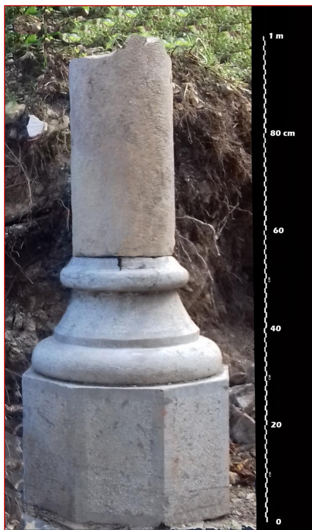
Cette photo montre bien le manque de cohésion du sol avec enfoncement de plusieurs centimètres.
