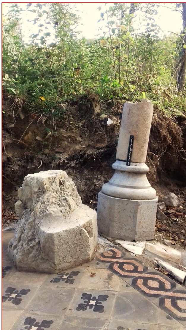
Les socles et colonnes ont été façonnés dans deux faciès lithologiques. Un à structure serrée et compacte à dureté forte, un autre plus poreux et se délitant.
