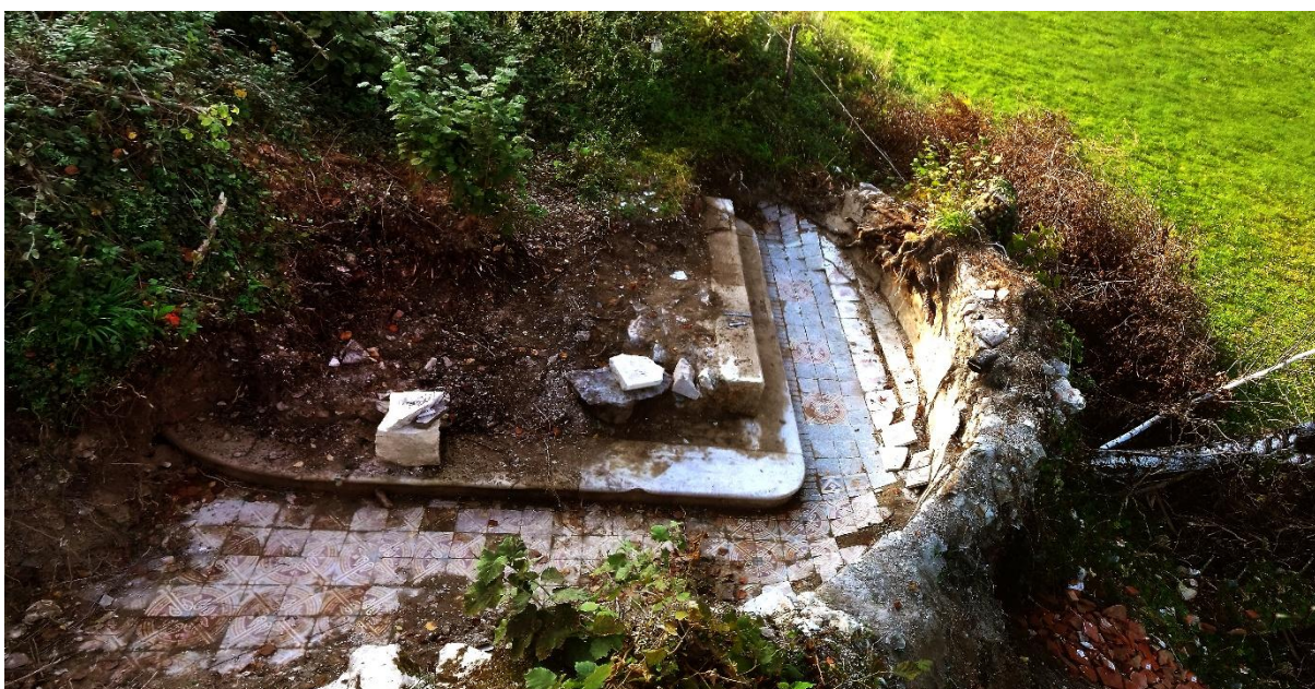
Partie dégagée (septembre 2025) du cœur (base de l'autel en partie conservée) et de l'abside. Le parement extérieur du chevet est très abîmé. Le système racinaire s'est développé à l'horizontale et a soulevé les carreaux extérieurs le long du mur.
