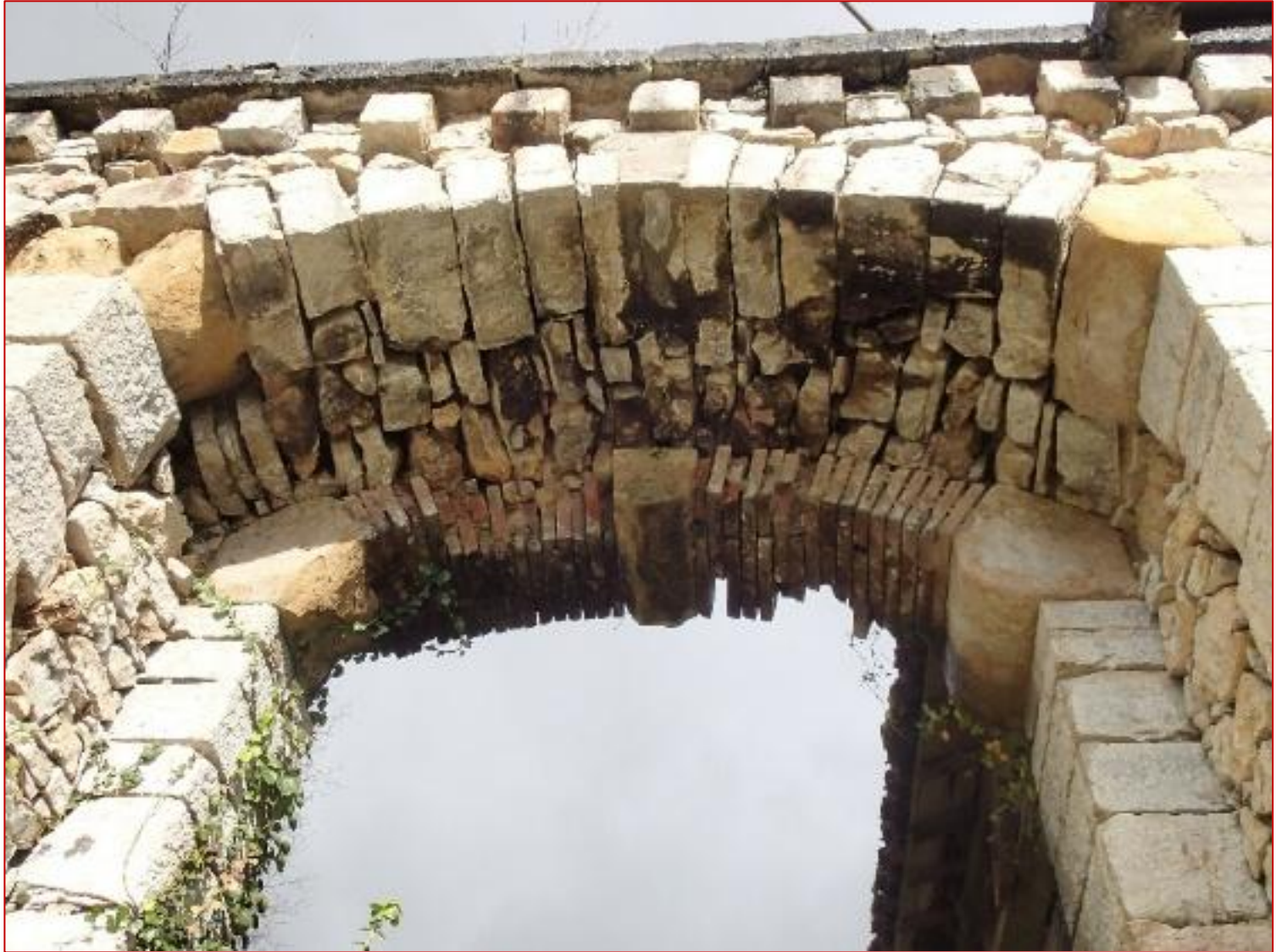
Hétérogénéité des claveaux de la voussure avec très peu de liant. On note aussi la présence de claveaux en grès dans les zones sensibles de supports des piliers droits.
