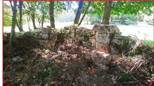
Délabrement du mur limite occidental avec les bases des piliers renforts
