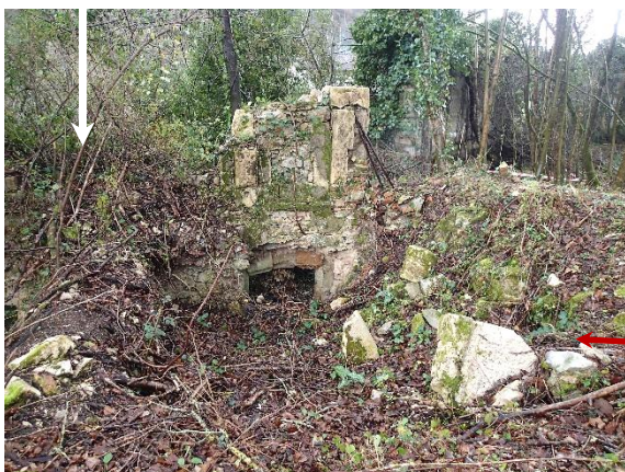
Délabrement des murs porteurs (zone est) et effondrement des toits des locaux en substructure (on devine le haut du porche de l'accès au local souterrain)
